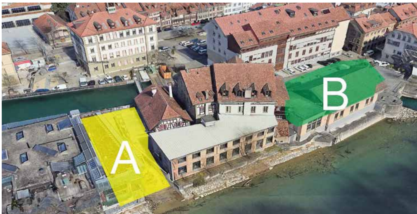
Wärmeverbund Matte – Standort der Wärmepumpenzentrale im alten Kraftwerk. Der Standort im Kupferstich ist aus technischer Sicht und aufgrund des Raumbedarfs für den Sequenziellen Speicher und die Installation der notwendigen Rückfallebene und der Spitzenlast nicht geeignet
