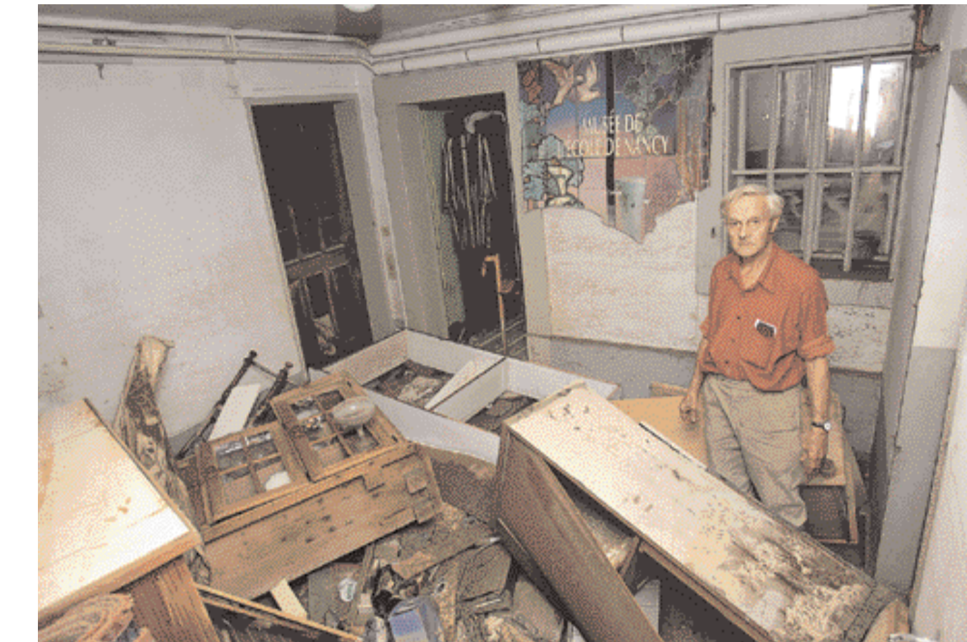
Das Wasser ist zurückgegangen, nun werden im Schlamm die Schäden sichtbar: Auch bei Fritz Gilgen in der Matte.
