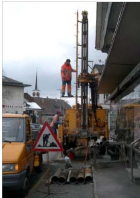
Bauarbeiter bei der Durchführung einer Sondierbohrung.
